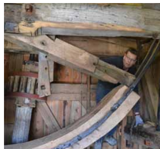
Peter Coppes: restauratie molen van Valburg
