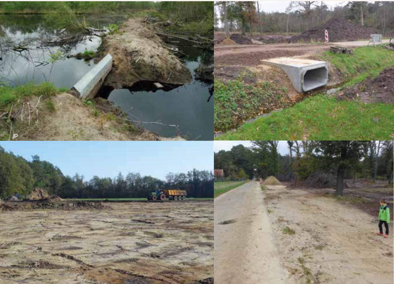
◀ Figuur 3: Herstelmaatregelen uit 2019 (met de klok mee): nieuwe stuw, net aangelegde natuurlijke drempelhoogte, gedempte sloot aan de Kuipersweg en verwijderen voedsel-rijke toplaag van de laggzone. Foto's: R. Ketelaar.
