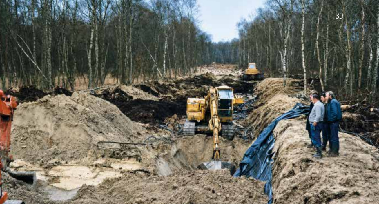
▲ Abbildung 1: Anlegen eines Deiches mit Folienabdeckung in 1980. Quelle: Naturmonumenten.
