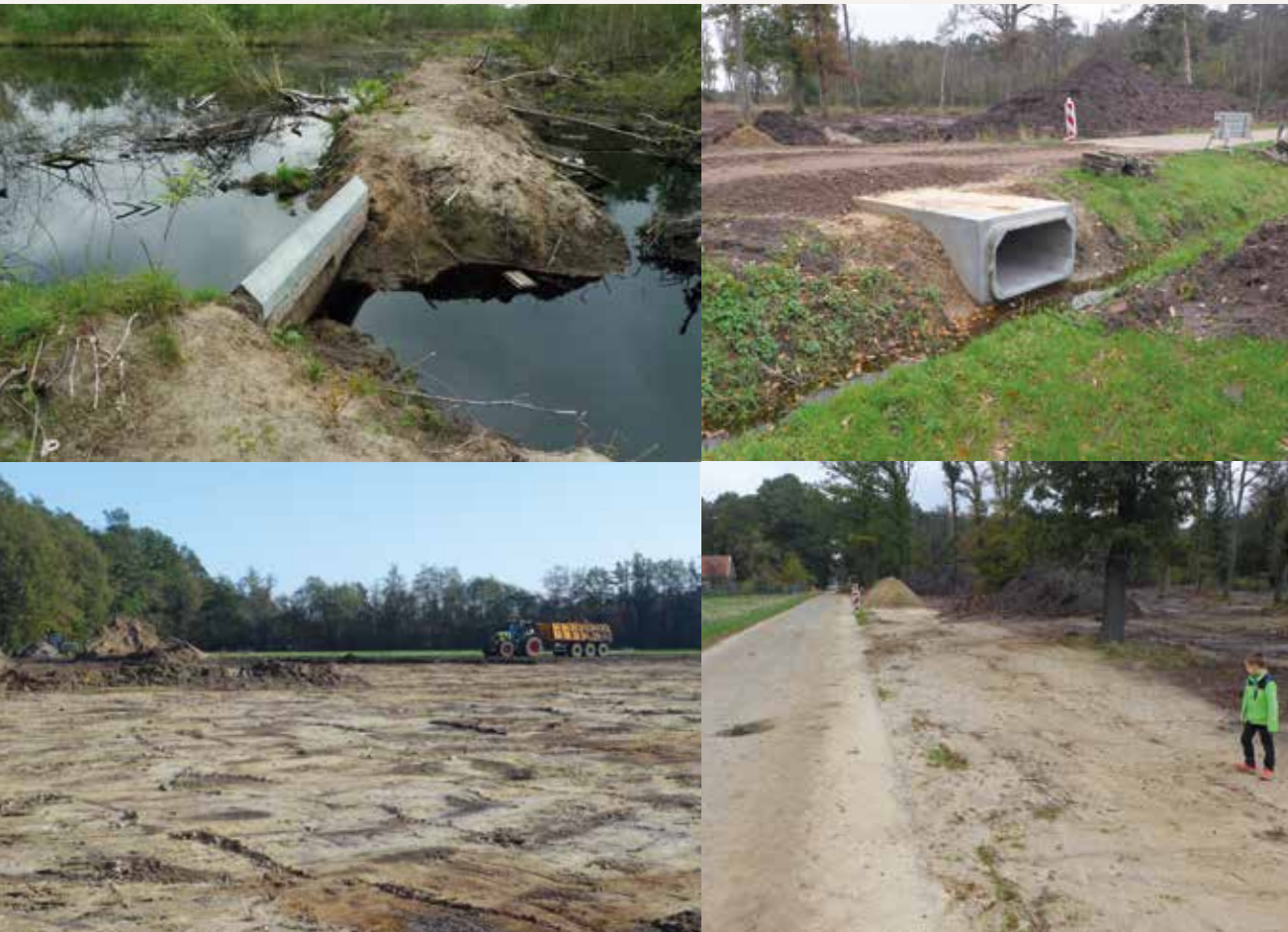
◀ Abbildung 3: Wiederherstellungsmaßnahmen aus dem Jahr 2019 (im Uhrzeigersinn): neues Wehr, neu angelegte natürliche Schwellenhöhe, aufgefüllter Graben am Kuipersweg und Entfernung der nährstoffreichen Deckschicht aus der Laggzone. Fotos: R. Ketelaar.
