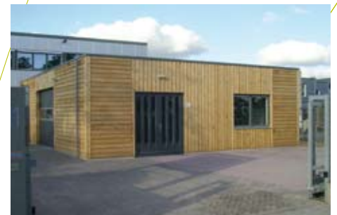
Potdekselplanken hollands red cedar loods Schiphol (foto Gerben Poortinga)
